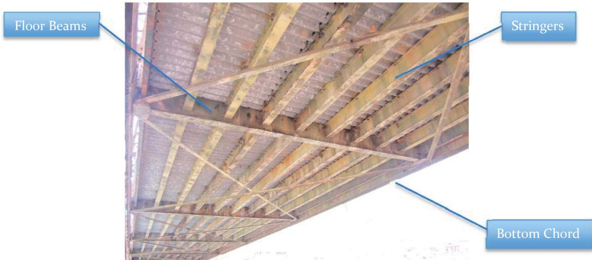
**FIGURE 1 - DECK SYSTEM COMPONENTS**
